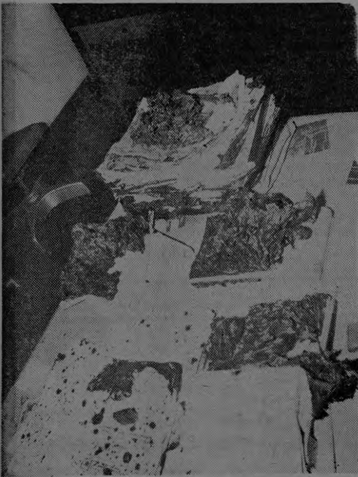
El interior del edificio de la Auditoría de la Cooperativa Dos Pinos no sufrió mayores daños gracias a la pronta intervención de los bomberos del Barrio Luján. Sin embargo papeles de mucha importancia fueron destruidos por las bombas molotov que elementos desconocidos lanzaron en horas de la madrugada de hoy. (Foto Córdoba).
